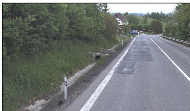
Obr. 7 – Pohled na silniční příkop s betonovou žlabovkou
